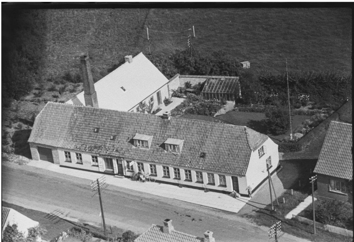
Koopmanns bageri med ny skorsten. I vinduet til højre for butiksdøren var konditori. Fra o. 1950.
