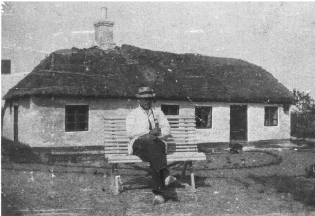
”Krybily” i Klim by. I dag er huset kraftigt ombygget. Fra o. 1910-20.
