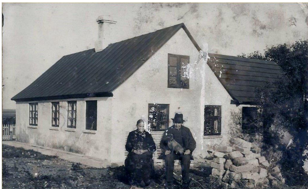
Line og Anders Tørks hus i Klim bygget i limsten. Bemærk stabel med overskydende limsten til højre.
