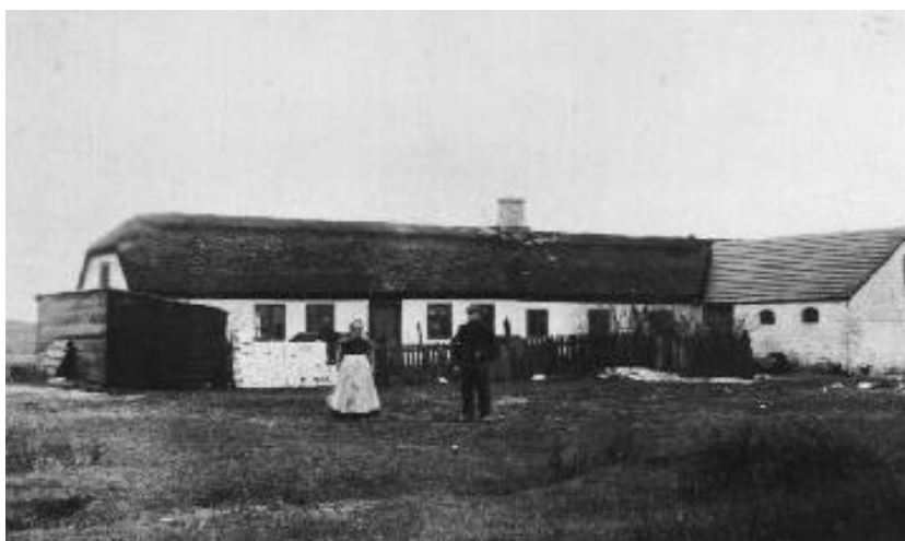
Et nu for længst forsvundet limstenshus i Klim Klit. Bemærk limstensstaben foran huset.
