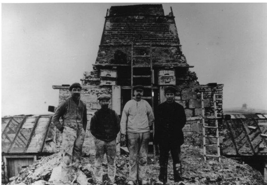
Brd. Andersens kalkværk under ombygning i 1916. Fra venstre ses Anders Møller, Martin Andersen, Peder V. Gregersen og Mads Toft. Til højre skimtes Nr. Mølle.
